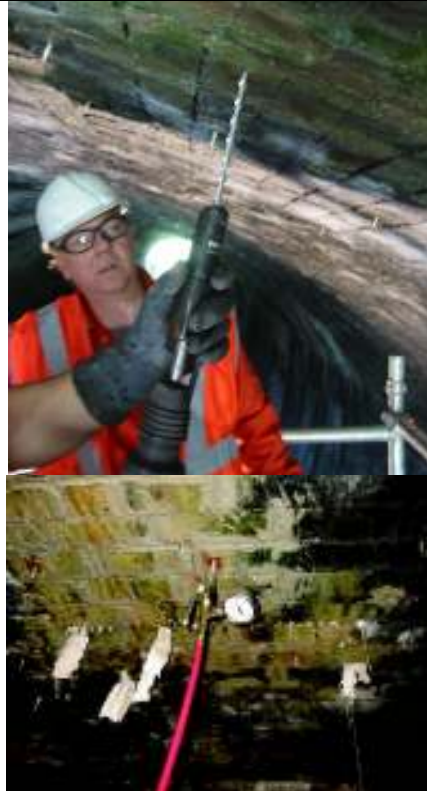
Einschrauben einer Injektionsspirale.
