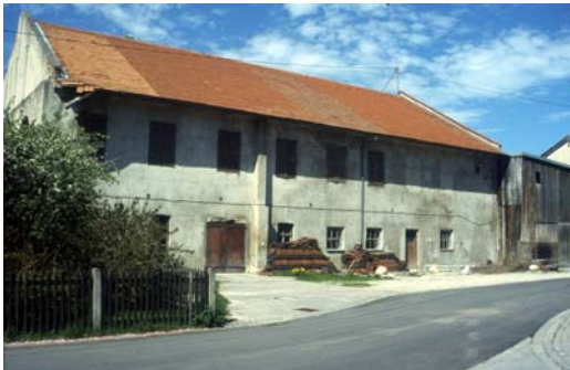
Bild 2: Blick auf die Ostfassade des denkmalgeschützten Ökonomiegebäudes der ehemaligen Klosterbrauerei Weyarn
