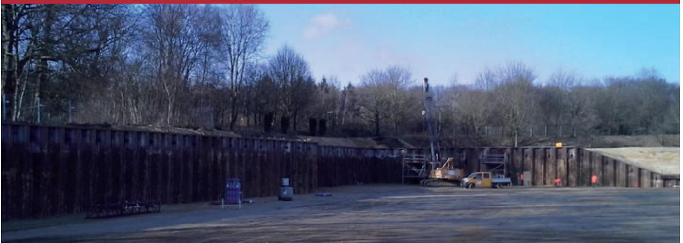
**>>** Hamburg: Ein Großhändler für Tiefkühlprodukte und Großküchentechnik ließ eine weit reichende Spundwand-Konstruktion zur Einfassung seines neuen, im Bau befindlichen Tiefkühlagers errichten. Die Strahl- & Sanierungstechnik GmbH & Co. KG aus Wildenhorst verlieh den Spundwänden mit unseren Beschichtungen verlässlichen Schutz gegen Korrosion und Witterung.
