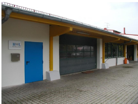
Das neue Firmengebäude in Neusäß/Vogelsang nahe Augsburg
