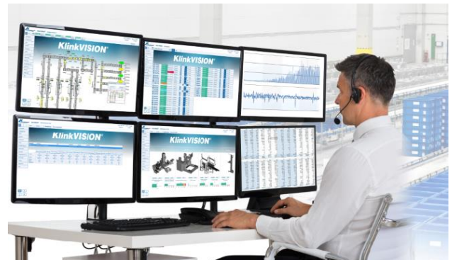
Bild 3: Live-Überwachung der automatisierten Logistikanlage am Leitstand
