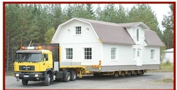
Ein spezielles Hebesystem des Herstellers ermöglicht das Heben der schlüsselfertigen Modulhäuser auf einen Anhänger und nach dem Transport auf das Grundstück. Dadurch ist es möglich, dass das Haus z.B. morgens, bei vorbereitetem Untergrund, geliefert wird, und abends bereits bezugsfertig ist. Das heißt: Sie können sofort einziehen und sich wohlfühlen!
