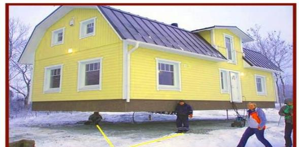
Sie sehen keine Fotomontage! Diese beiden Personen stehen vor je einer Hydraulik-Stütze, die das Haus in dieser Höhe halten. Der Tieflader, der das Haus angeliefert hat, konnte somit unter dem Haus wegfahren. Das Haus wird danach hydraulisch abgesenkt und die Stützen vom Inneren der Bodenplatte durch Revisionsöffnungen entnommen.
