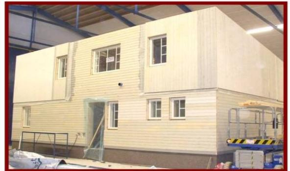
Das Gebäude wird von dem Hersteller auf einem wärmegeämmten und RADON geschützten 49 cm starken selbsttragenden Stahlbeton-Guss-Fundament bereits mit kompletter Innenausstattung ausgeliefert. Dach, Türen, Fenster, Rolläden, Heizung, Haus –und Sanitär-technik, Schränke, moderne Küchenmöbel, Kamin und Lampen, und in den Bädern und im Außenbereich sind schon bezugsfertig montiert.
