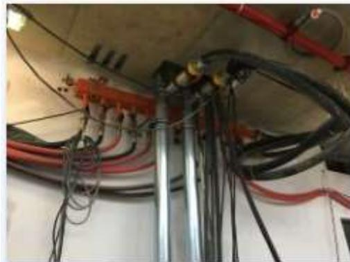
Selbstverständlich wurden auch die Unterverteilungen im Rohbau so montiert, dass die Ausbauewerke fast ungehindert ausgeführt werden konnten.
