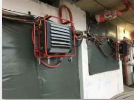
Komplett autark, die gemietete, mobile Heizanlage von „mobiheat“ der Produktlinie Orange, bestehend aus: Heizzentrale im robusten Stahlcontainer mit 2 MW Leistung, Heizöltank mit 10.000 l Fassungsvermögen, 45 mobile Lufterhitzer des Typs MHL50 sowie der notwendigen Unterverteilungen und Schlauchleitungen.
