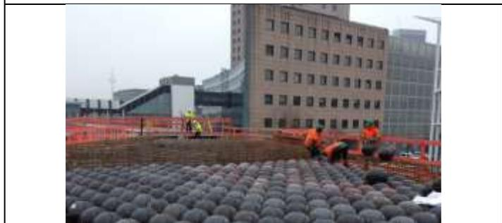
Verlegung der Cobiax-Kunststoffhohlkörper aus recyceltem Kunststoff auf einem Teilbereich der Decke über EG.
