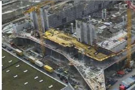
Die auskragende Betondecke über dem EG auf der Ostseite ist bereits fertig und die Betonage der Decke über dem OG in Vorbereitung.
