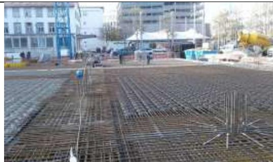
Beim Projekt in der Zielstattstraße 27 wurden zum Erzielen großer Deckenspannweiten und Stützenraster auf insgesamt 13.200 m<sup>2</sup> Deckenfläche ca. 68.500 Slim-Line-Hohlkörper verlegt und einbetoniert.
