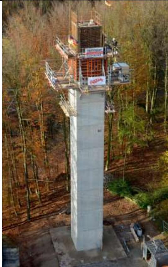
Mitte November 2017 waren die Stahlbetonarbeiten für den 31 m hohen Aufzugsschacht fast abgeschlossen. Der zügige Baufortschritt wurde signifikant durch die PASCHAL-Systeme unterstützt, denn eine komplette Klettereinheit aus senkrechter Schaleinheit mit Bühne/n und Schutzgerüst/en wird nur einmal verheiratet und mit nur einem Kranhub an den nächsten Einsatzort gehoben.
