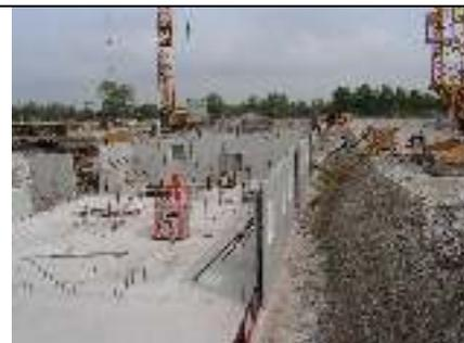
Weißer Wanne aus Elementwand-Fertigteilen - in diesen Bauverfahren wurden im HaidPark mehrere Basisgeschosse als Weiße Wannen ausgeführt, um dauerhaft dichte Basisgeschosse zu gewährleisten.
