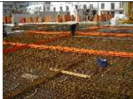
Das System Drytech sorgt auch für die wasserdichte Tiefgaragendecke im nicht überbauten Bereich. Ein Abdichtungstechniker montiert die DRYset Sollrissprofile im Boden/Bodenbereich. Durchschnittlich werden die Bewehrungskosten je Baustelle, bei der das System Drytech zum Einsatz kommt, um 30% reduziert.
