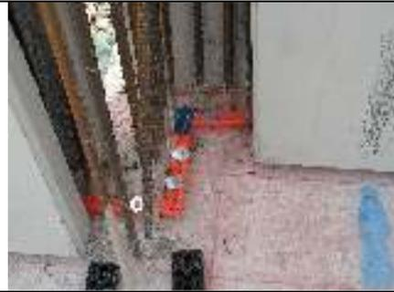
Bei der Kombination von Elementwand-Fertigteil und Ortbeton ist der Fugenausbildung besondere Aufmerksamkeit zu widmen. Im Fugenbereich entstehen meist feinste Kapillare die unweigerlich zur Undichtigkeit führen. Das Abdichtungssystem von Drytech verhindert genau an diesen Übergängen, dass es zu Undichtigkeiten kommt.
