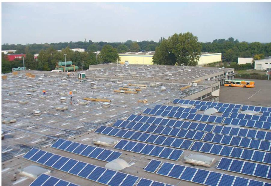
Die Dachabdichtung ist nach Aufbringen der Photovoltaikanlage zum großen Teil nicht mehr einsehbar. Die Ortung von Leckagen ist dann ohne die Deinstallation der Photovoltaikanlage nahezu unmöglich, es sei denn ein Leckmeldesystem ist in das Dach integriert.
