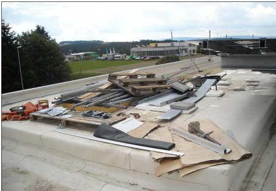
Eine typische Situation auf einem Flachdach während der Errichtung einer Photovoltaikanlage. Beschädigungen der Dachhaut sind hier sehr wahrscheinlich.
