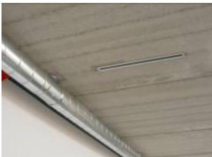
*Für die Auslässe der Lüftungsdecke stehen wahlweise Tellerventile oder Schlitzauslässe zur Verfügung. Die entsprechenden Aussparungen sind bereits werksseitig integriert.*
