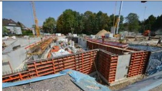
Lange Stahlbetonwandscheiben, rechtwinklige Außen- und Innenecken lassen sich wie hier in Münster mit dem System LOGO.3 maßgenau und schnell im System Schalen, für ein perfektes Ergebnis.
