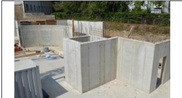
Nach dem Ausschalen zeigen sich perfekt geschalte und betonierte Stahlbetonkonstruktionen. Im Hintergrund die mit der TTR rund geschalte Tiefgaragen Zu- und Ausfahrt und im Vordergrund einer der 5 Fahrstuhlschächte, für den Averbek 4 Ausschal-Innenecken mit 4 Elementen der LOGO.3 kombinierte.
