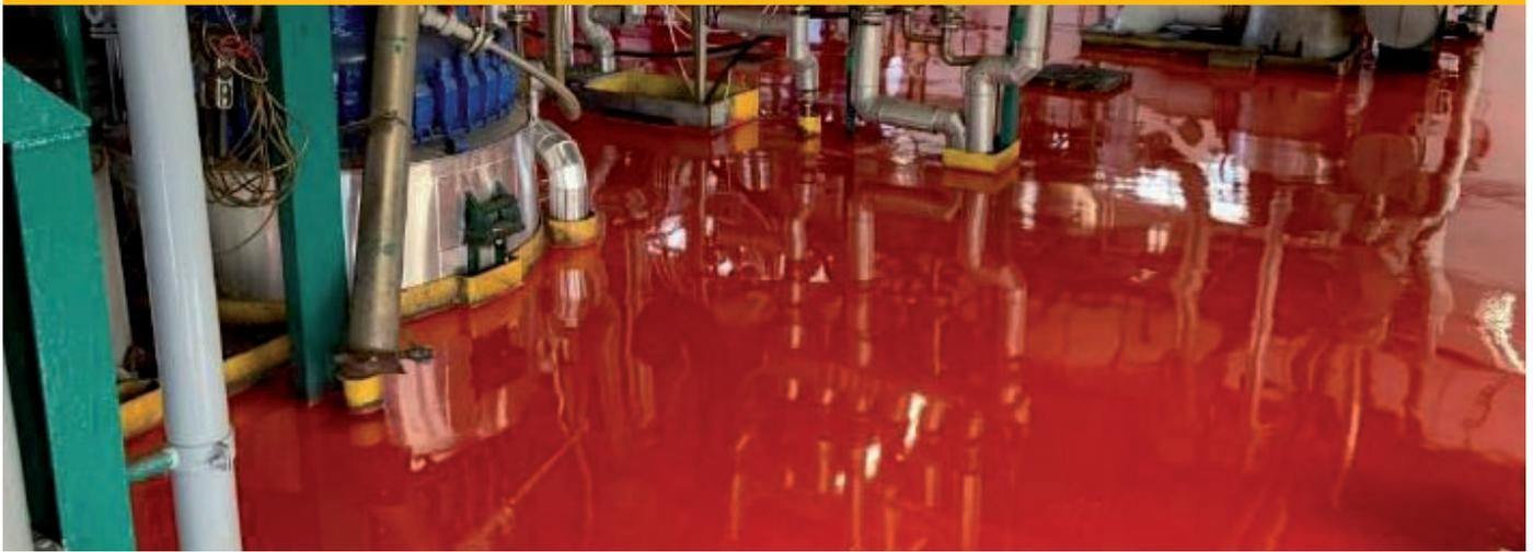
Mailand/Italien: Durch hohe mechanische Belastungen und aggressive Chemikalieneinflüsse zeigte der Industrieboden des Pharmaunternehmens nach einer Betriebsdauer von 7 Jahren starke Schäden. Für den dauerhaften Schutz des Bodens wurden die CP-Synthofloor-Systeme ausgewählt, welche die besonderen Anforderungen Antistatik und Rutschfestigkeit souverän erfüllen.
