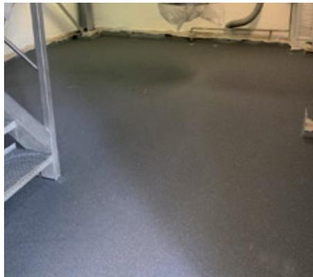
Modul 6: **SIC (Siliziumkarbid)** wurde auf die noch nasse Beschichtung aufgestreut um eine rutschfeste Oberfläche bei Bewahrung der Leitfähigkeit zu erhalten; ca. 4 kg je Quadratmeter wurden benötigt.
