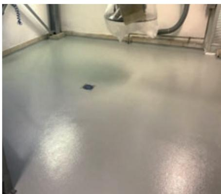
Modul 7: Die Deckschicht **CP-Synthofloor 8481 A.S.** ist als elektrostatisch ableitfähiges Produkt auch für Bereiche mit Explosionsgefahr geeignet. Es bietet hohe chemische und mechanische Stabilität, der Erdableitwiderstand RE ist  $< 10^9 \Omega$  für die rutschhemmende Beschichtung.
