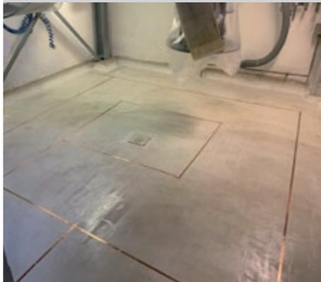
Modul 1-3: Unser Produkt **CP-Synthofloor BETA 8016** wurde als Grundierung sowie als Kratzspachtel appliziert, um den Untergrund abzudichten und zu nevellieren. Der nächste Schritt war die Aufbringung und Erdung des Kupferleitbandes.
