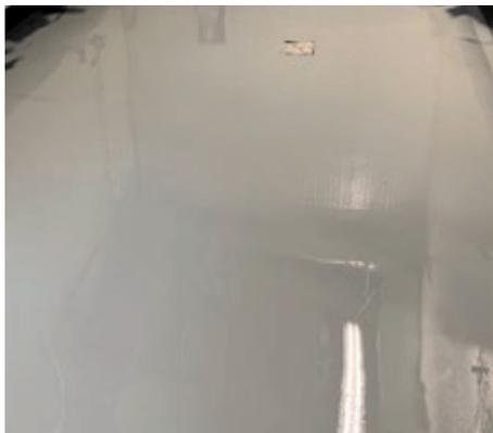
Modul 5: Nun wurde **CP-Synthofloor 8460 A.S.** appliziert – ein System mit elektrostatisch ableitfähigen Polymer-Strukturen. Dieses Produkt bietet eine hohe mechanische und chemische Resistenz.
