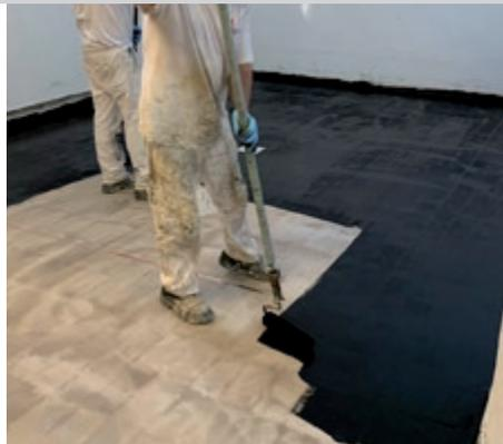
Modul 4: **CP-Synthofloor 8860 LS-AS** – die Leitschicht – wurde ebenfalls per Rolle aufgetragen. Diese Zwischenbeschichtung zeigt einen Widerstand von  $1 - 5 \times 10^3 \Omega$ .
