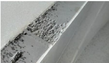
Die freigestrahlten korrosionsgeschädigten Bereiche wurden mit unserem Spezialcomposite-Spachtel PROGUARD CN 200 THIX aufgefüllt und geglättet.
