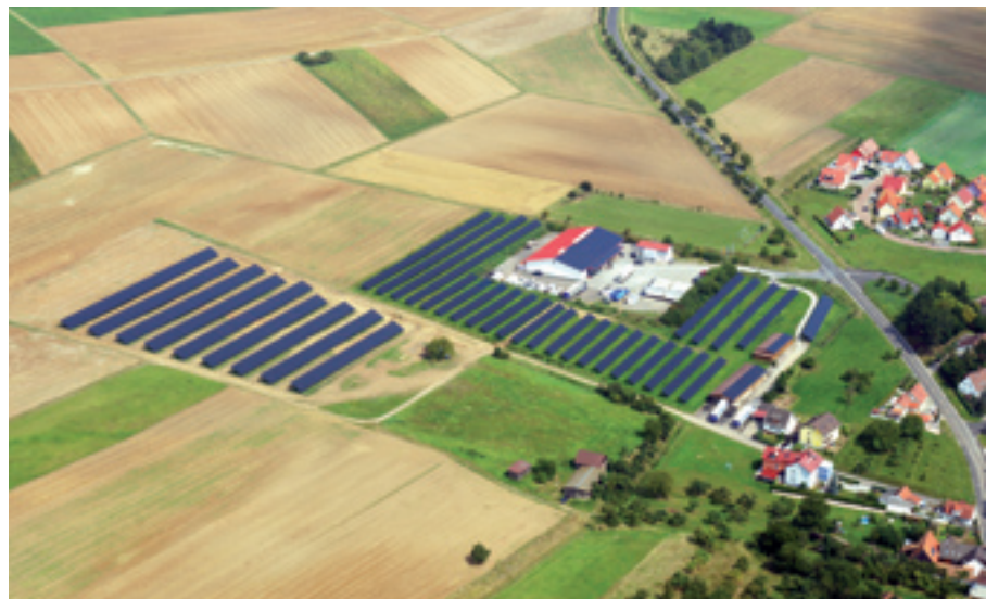
Luftaufnahme des Löb-Firmengeländes mit Photovoltaikanlagen
