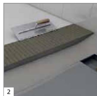
Auf die alternative Abdichtung (wedi Tools Dichtband und Fundo Dicht-Set) – im Übergangsbereich des Fundo Bodenelementes zum Estrich – wedi 320 Fliesenkleber auftragen ...
