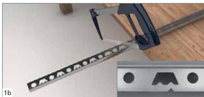
... kann aber z.B. bei der Verwendung eines 900 mm langen Fundo Riolito Bodenelementes leicht an der gekennzeichneten Kerbe abgelängt werden.
