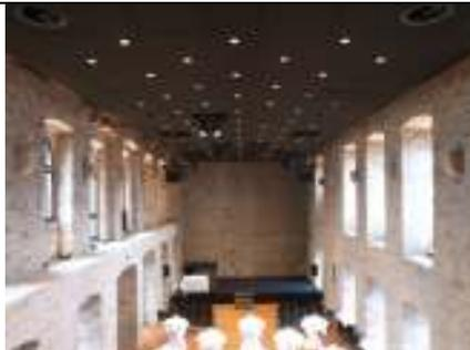
Der modernisierte Festsaal mit modernster Akustikdecke, die alle technischen Einbauten aufnimmt. So konnten die Umfassungswände im ursprünglichen Stil erhalten bleiben.
