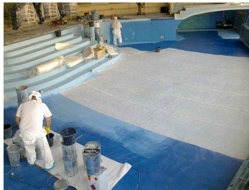
Bild 2: Verlegung Spezialfliesmatten
