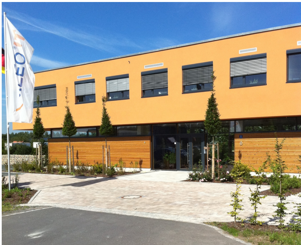
Bild 2: Die neue Firmenzentrale von Valeo IT in Luhe-Wildenau (Foto: Valeo IT Gruppe).
