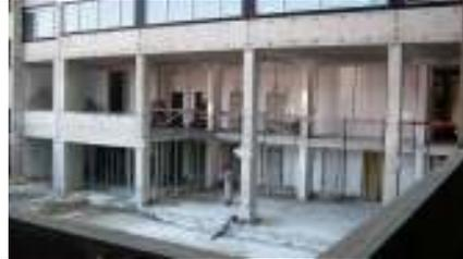
Das Foyer verbindet die Gebäude 116, 116A und 116B und erschließt jetzt über eine eingebaute Treppenanlage das Kasino. Dafür wurden die drei ehemaligen Eingänge zusammengelegt, die Decke des Erdgeschosses in Teilen herausgeschnitten und die Flächen erweitert.
