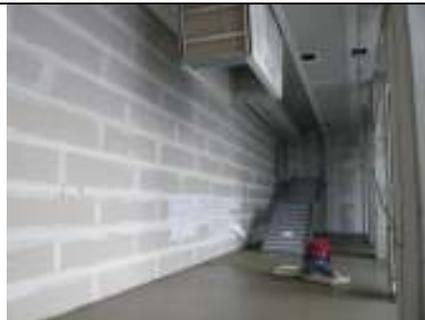
Die Foyertrennwand wurde, geschuldet aus dem Brandschutzkonzept, als F90 Wand ausgeführt. Die Befestigung der REC Platten konnte in Abstimmung mit Knauf durch Verklebung realisiert werden.
