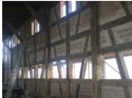
Das freigelegte und sanierte Fachwerk wurde vor dem Ausfachen mit Leinöl behandelt. Als zusätzlicher temporärer „Holzschutz“ wurde vor dem Ausmauern die Holzkonstruktion abgeklebt.
