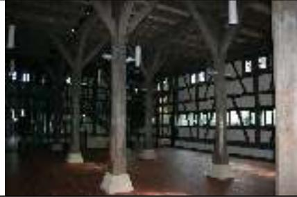
Zur Ausfachung der Fachwerkskonstruktion wurden rund 50 m<sup>3</sup> Bisootherm Bims-Vollsteine verarbeitet.
