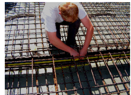
Verbinden der Sollrissfugenelemente
