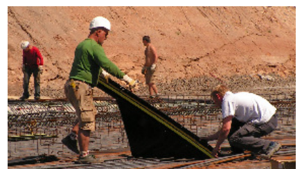
Sollrissfugenelement mit Verbreiterungsglasche
