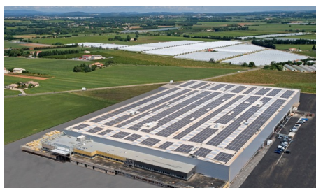
La Poste, Montpellier, Frankreich, 700 kWp
