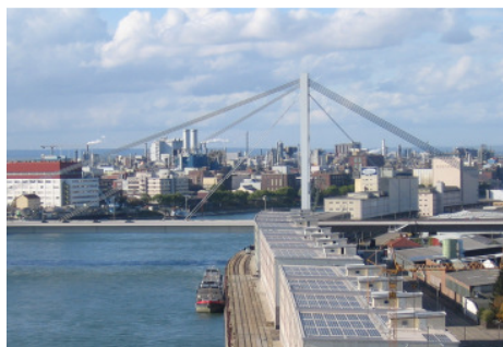
Hafenbetriebe Mannheim, Block I, II und III, Deutschland 370 kWp
