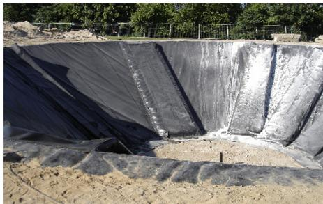
Die Wärmedämmung Poraver in HDPE-Sperrschicht-Kammern, zum Dämmen eines Erdbeckenwärmespeichers.
