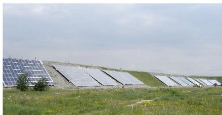
Solarzellen zum Einfangen der Sonnenenergie, säumen den aufgeschütteten Rand des Wärmespeichers.
