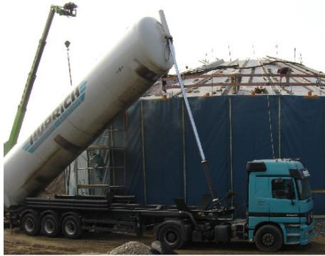
Der Einblasvorgang zum Dämmen des Wärmespeichers in München wird vorbereitet.
