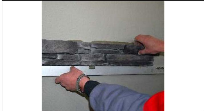
Rückseite säubern – hier gut zu erkennen die haufwerksporige Rückseite, die eine optimale Haftung des Klebers ermöglicht.
