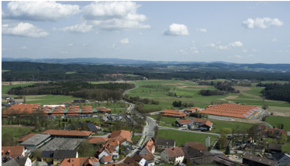
Bild 1: Luftaufnahme des Witron-Standortes in Parkstein mit Werk 1 (vorne links), Werk 2 (Mitte links), Logistikhof und Werk 3 (Mitte rechts) (Foto: Witron).
