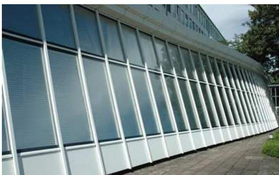
Die Sonne ist unser wichtigster Energiespender – ein Zuviel davon wird allerdings schnell zur Belastung. Im Sommer dient ein Rollo als Wärmedämmung. In der Nacht und im Winter, helfen die Rollos den Wärmeverlust zu reduzieren.
