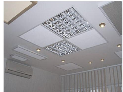
Bei einer herkömmlichen Heizung benötigen sie für eine Wohneinheit von ca. 150 m<sup>2</sup> einen Wärmespeicher von ca. 15-20 KW. Gegenüber beheizt mit **Suntherm** -Wärme benötigen sie ca. 9 KW. Da die **Suntherm** -Paneele durch die Einfachheit der Installation sowie kleineren Investitionskosten und den niedrigen Verbrauchskosten, in keinem Verhältnis zu einer traditionellen Heizung stehen, ergibt sich praktisch ein auf unbegrenzte Lebensdauer zukunftsweisendes und hochwirksames Heizsystem.
