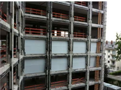
**Bild 2:** Mobiler Lärmschutz – wie hier auf einer Baustelle – kann flexibel und dennoch effektiv sein. Die Lösung sind Lärmschutzwände aus aufblasbaren Elementen.
