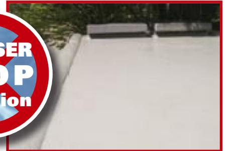
Nach ca. 6 Stunden kann der 2. Beschichtungsvorgang erfolgen. Die Fläche ist nach ca. 24 Stunden voll belastbar.
