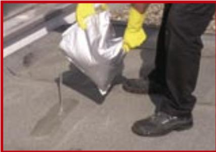
**Alfa FlachdachDICHT** ist gießfähig und wird portionsweise direkt auf die horizontale Fläche aufgebracht.
