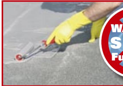
Anschließend wird **Alfa FlachdachDICHT** mit der Beschichtungswalze gleichmäßig verteilt. Die beschichtete Fläche ist sofort wasserundurchlässig.
