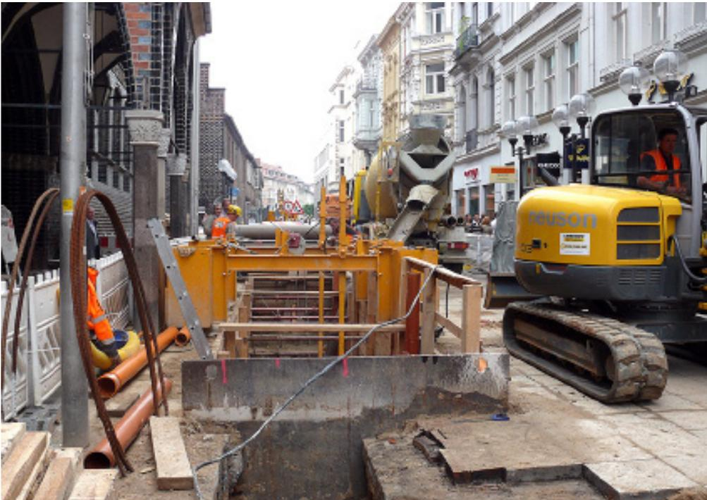
*Ein Fahrmischer bringt den Flüssigboden in den Kanal ein. Die Säulen am historischen Rathaus werden bei dieser neuen Technologie vor dem Angriff der Rüttelplatte verschont. Die ungestörte Situation vor der Aufgrabung wird wiederhergestellt.*
