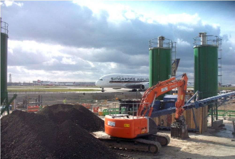
*Der Flüssigboden wird in einer **Kompaktanlage** unmittelbar im Baustellenumfeld hergestellt – so wie auf dem Foto auf einer Baustelle am Flughafen London Heathrow. Die für die Herstellung von Flüssigboden entwickelte Technik ist in der Lage, das Verfahren in all seinen Unterschieden zur reinen Misch- und Betontechnologie korrekt umzusetzen.*
