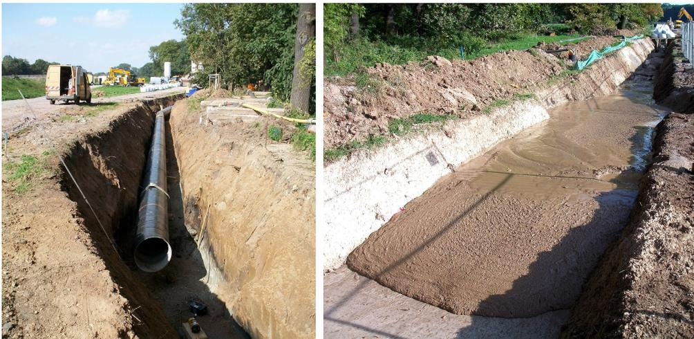
*Am Leipziger Luppedeich wurden neue Trink- und Abwasserleitungen in Flüssigboden nach RAL Gütezeichen 507 verlegt. Dabei wurde der Aushubboden, der teilweise stark humin belastet war, verwendet. Dies sparte Zeit und Kosten und gefährdete in keiner Weise den Hochwasserschutz. Das RSS Flüssigbodenverfahren weist viele weitere Vorteile auf.*
