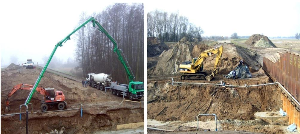
*Flüssigboden (Ausführung mit RSS Flüssigboden entspr. den Anforderungen des RAL Gütezeichens 507) lässt sich schnell und einfach mit hoher Einbauleistung und wenig Personal sowie wetterunabhängig einbauen – so geschehen nach dem Hochwasser 2002 am Oderdeich, Güstebieser Lose.*
