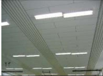
Neben mechanischen und akustischen Beanspruchungen wird die Deckenverkleidung (Plattensystem Mikropor G\_bs ) ergänzenden Anforderungen gerecht: Brandschutz, Ökologie, Raumklimaregulierung, Luftfeuchtebeständigkeit und Lichtreflexion.
