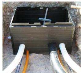
In diesem Fertigteilschacht laufen Fernmelde- und Glasfaserkabel zusammen.
