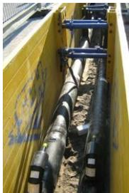
Rohrgraben mit zwei verschweißten und gemufften Fernwärmerohren.
