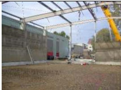
Auch bei der Montage in Mörfelden war keine Einrüstung zur Montage der Thermodur Wandelemente nötig.
