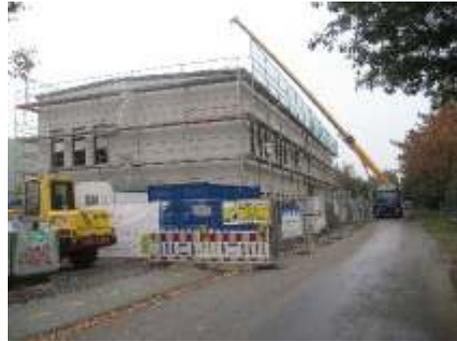
Die Leichtbetonwandelemente wurden montagefertig mit einem Mobilkran vom Transportfahrzeug direkt an die Stahlkonstruktion herangeschwebt und durch eigene Fachkräfte montiert.
