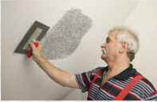
Sajade dünn und gleichmäßig auf der Fläche auftragen.
