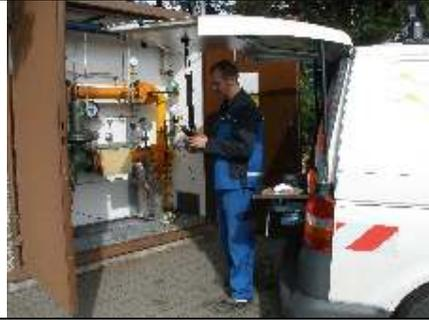
Nach Abschluss der Datenpflege werden die nun anfallenden IH-Aufträge von K3V generiert und vor Ort über ein elektronisches Druckmessgerät, dem GaWaEx der Firma Esders, auf den K3V-Viewer übertragen. Die auf den mitgeführten Toughbook gesammelten Daten werden nach Abschluss der IH-Maßnahmen ausgelesen und auf der K3V-Datenbank aktualisiert.
