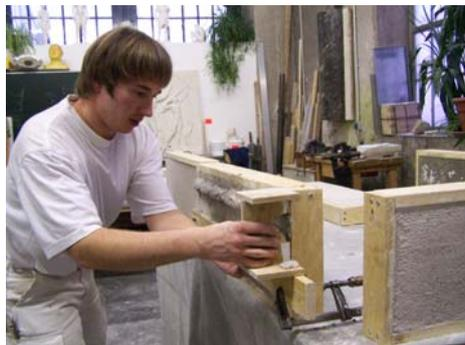
**Bild:** Stuckateur Stephan George bei der Rekonstruktion eines gezogenen Stuckprofils
