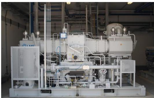
Das Herzstück der Biogaseinspeiseanlage: der Verdichterraum. Hier wird das Gas auf Betriebsdruck gebracht.
