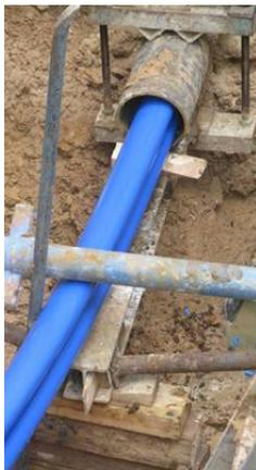
*Mennicke führte die Sanierung des Trinkwassersystems im Schweinfurter Schulzentrum mithilfe des Close-Fit-Verfahrens durch.*
