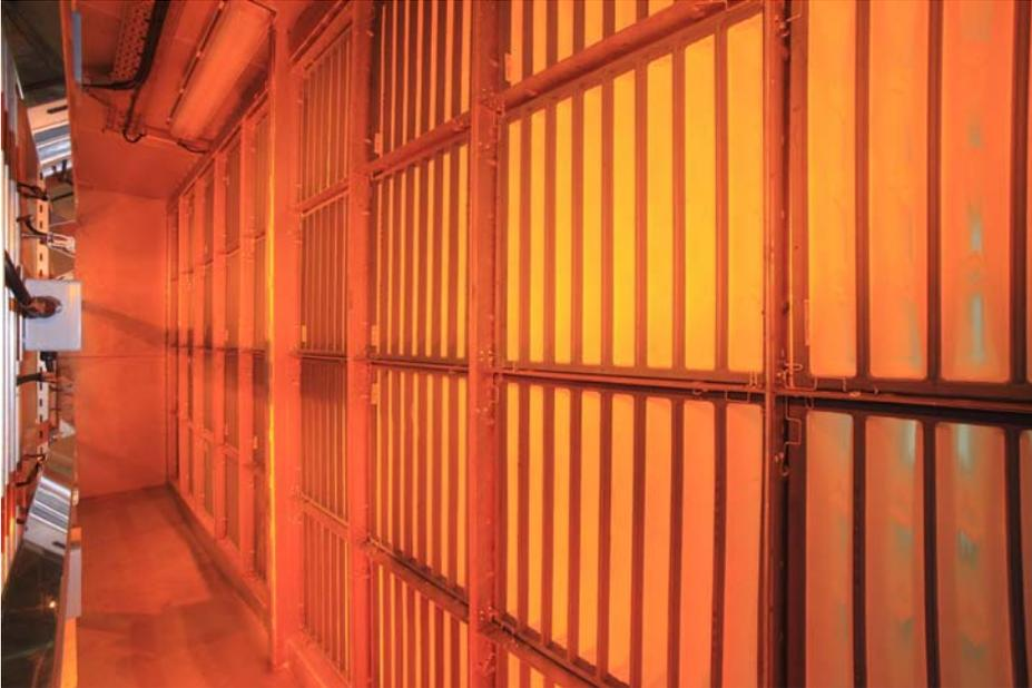
Infrarot-Strahler von Heraeus Noblelight erwärmen Filter einer Gasverdichtungsstation, damit sie eisfrei arbeiten können.
