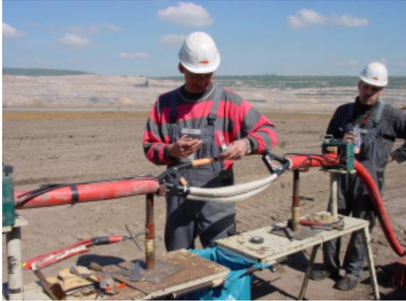
Vor Ort setzen die Techniker beschädigte Leitungen schnell instand – sogar im offenen Gelände.
