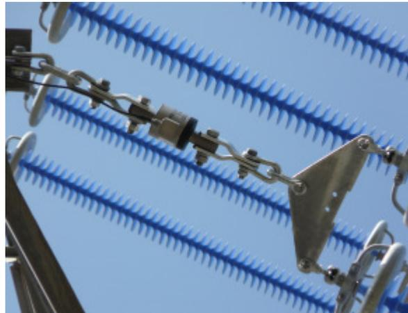
Der zylindrische Körper im Bild ist eine Kraftmesszelle von CAT-1, dem Nexans-Echtzeit-Monitoring-System für Übertragungsleitungen.
