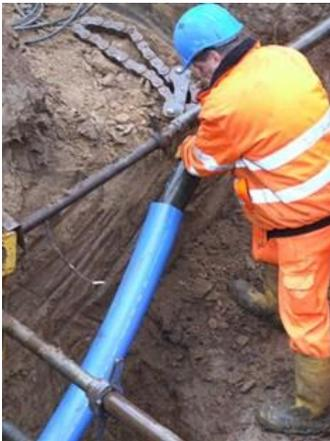
*Der Close-Fit-Liner wird in das Altrohr eingezogen und schmiegt sich anschließend unter Einleitung von Dampf und Druck nahtlos an die Rohrwand an.*
