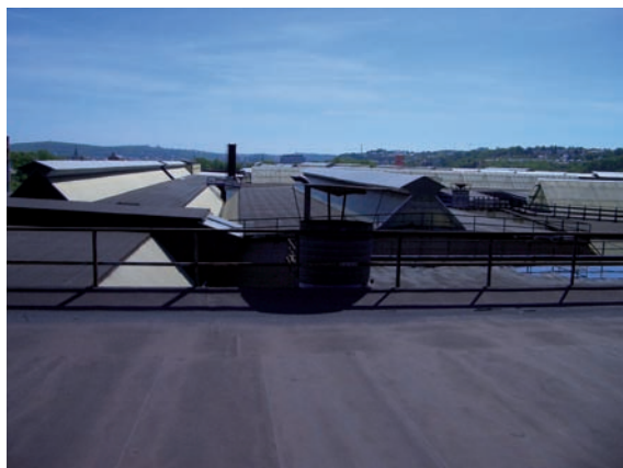
Bild 2: Fertig verlegte Bitumenbahn
