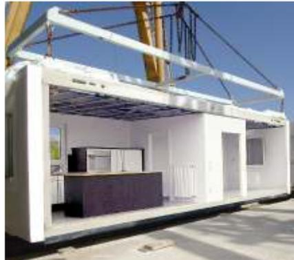
Die Vorfertigung im einzigartigen Massivhauswerk wurde im Laufe der Jahre so perfektioniert, dass selbst komplett ausgestattete Küchen- und Badmodule die Praxis sind. Auch bestellte Echtglasduschkabinen werden im Werk eingebaut.
