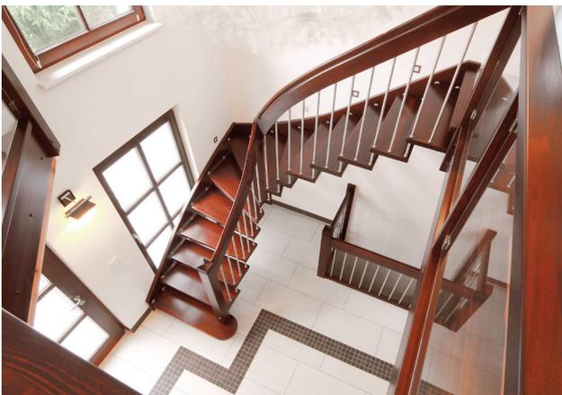
Die ein-viertel-gewendelte Tragbolzentreppe besitzt 15 Steigungen. Die Stufen werden in der Wange von Stahlbolzen in Gummikonsolen getragen. Das schont sowohl Wirbelsäule als auch Gelenke beim Auf- und Abstieg. (Foto: STREGER)
